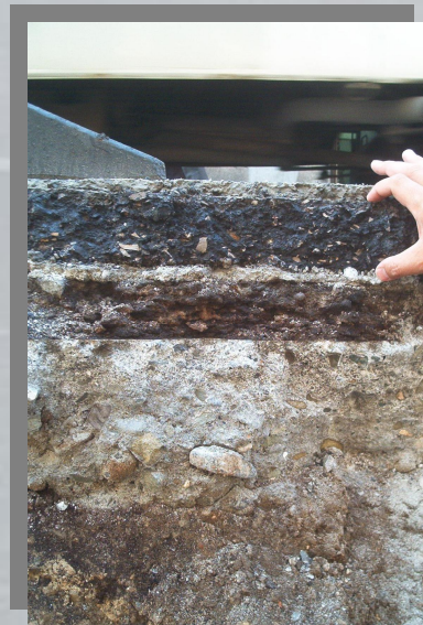
Rys. 2 Typowy przekrój jezdni
