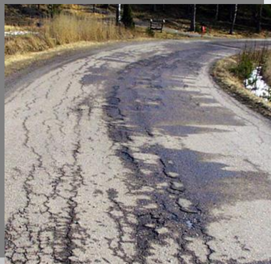
Rys. 1 Przykład uszkodzonej nawierzchni drogi
